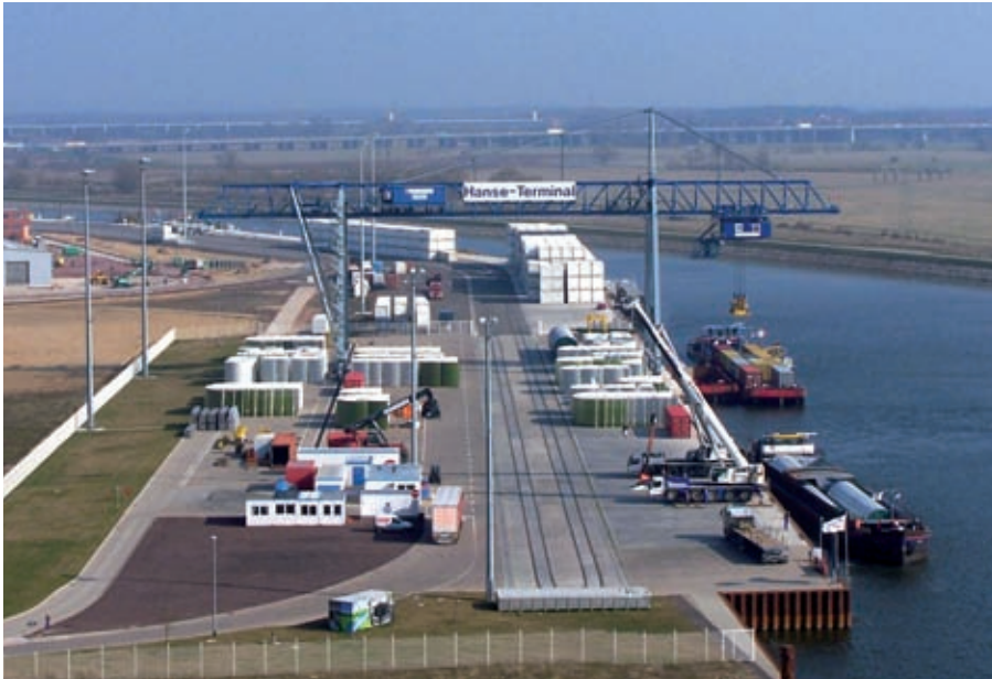
Abb. 11: Der Magdeburger Hafen mit dem Hanse-Terminal bietet durch seine trimodale Schnittstelle zwischen Lkw, Bahn und Binnenschiff intelligente Verzahnung für einen wirtschaftlichen und umweltverträglichen Güterverkehr. Damit wird er innerhalb des Galileo-Testfeldes Sachsen-Anhalt zum begehrten Logistik-Testfeld für Anwendungsentwicklungen in Telematik und Logistik.
