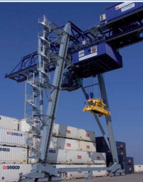
Abb. 10: Container-Umschlag im Magdeburger Hafen mit Hanse-Terminal.
