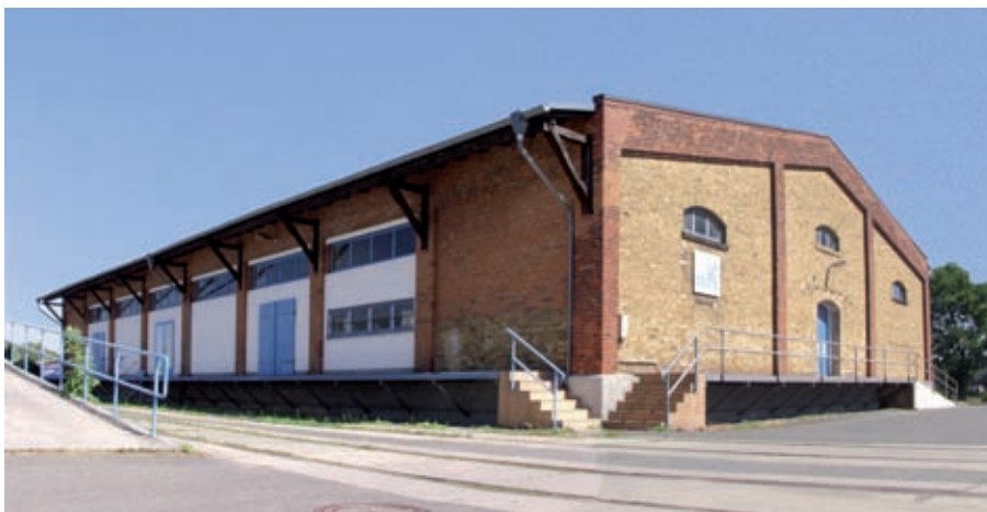
Abb. 7: Im Inneren der unscheinbar wirkenden Messhalle des Galileo-Testfeldes und der angrenzenden Freifläche auf dem Gelände des Wissenschaftshafens Magdeburg ist hochwertige Technik im Wert von ca. 2,2 Millionen Euro installiert.
