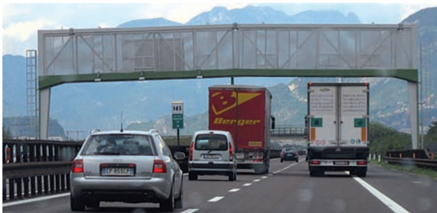
Abb. 21: Wie gelangt die Information in die Bahn oder zum Autofahrer? In der Straßenbahn (siehe Abb. 20) sorgt dafür eine Sendeeinheit. Autofahrer werden per Infrastructure-to-Car-Kommunikation mit Hilfe einer Überkopfanzeige informiert.
