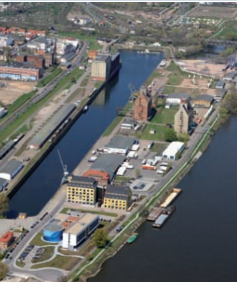
Abb. 8: Der Wissenschaftshafen Magdeburg dokumentiert den Wandel vom Handelshafen zum Wissenschaftsstandort in der Landeshauptstadt.
