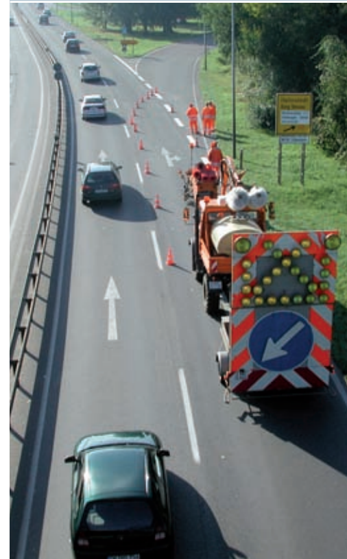
Abb. 25: Baustellen wie diese auf dem Magdeburger Ring sind künftig keine Überraschung mehr für die Verkehrsteilnehmer. Sie werden über das Verkehrsmanagement vorab informiert und können rechtzeitig über Alternativen entscheiden.
